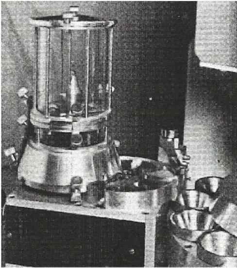
Les ensacheuses et les micro-doseuses sont équipées d'un doseur de son invention dit à sillons : ce système permet un dosage très précis et le réglage est facile.
